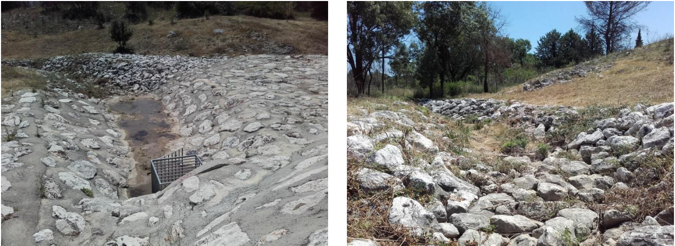
Figure 49 : A gauche, débouché de la buse de fuite actuelle et enrochements liaisonnés / A droite : enrochements libres dans le lit du cours d'eau en aval
