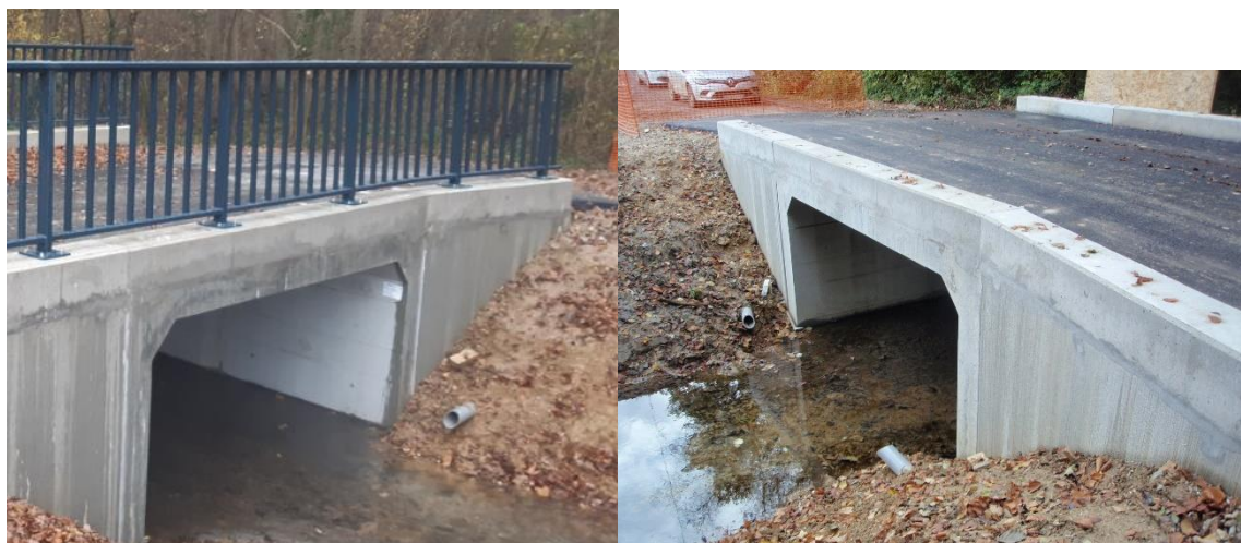
Figure 84 : Chantier en cours, exemple d'ouvrage cadre à CROTH (27)
